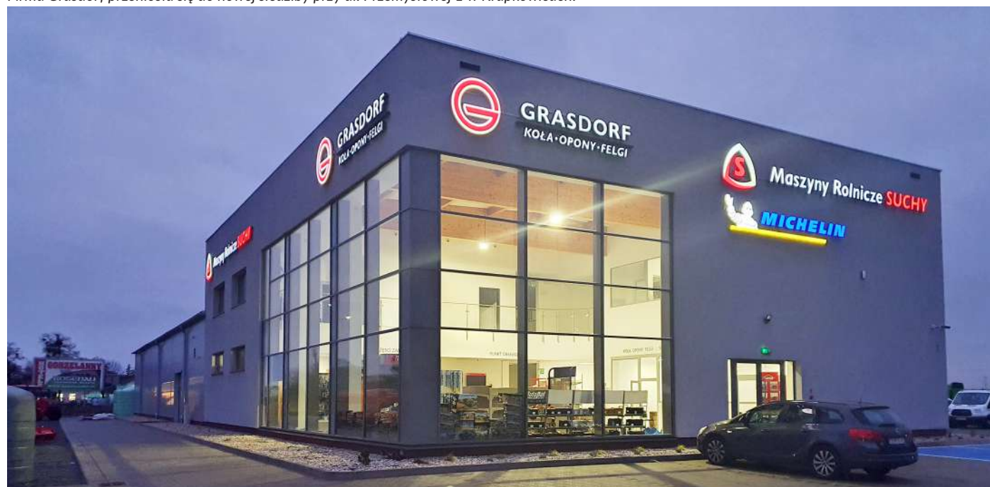
Firma Grasdorf przeniosta się do nowej siedziby przy ul. Przemysłowej 1 w Krapkowicach.
