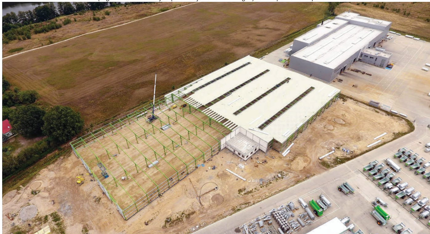
Firma Joskin Polska od marca bieżącego roku rozbudowuje się. Powstaje nowa hala magazynowa o powierzchni ponad 12 000 m 2 .
